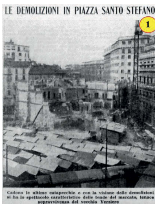
LE DEMOLIZIONI IN PIAZZA SANTO STEFANO Cadono le ultime catapecchie e con la visione delle demolizioni si ha lo spettacolo caratteristico delle tende del mercato, tenace sopravvivenza del vecchio Verziere
