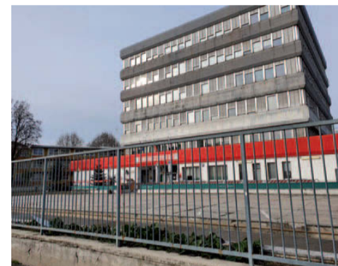
Il centro civico di via Oglio 18, la cui cancellata verrà arretrata per creare uno spiazzo con sedute.
