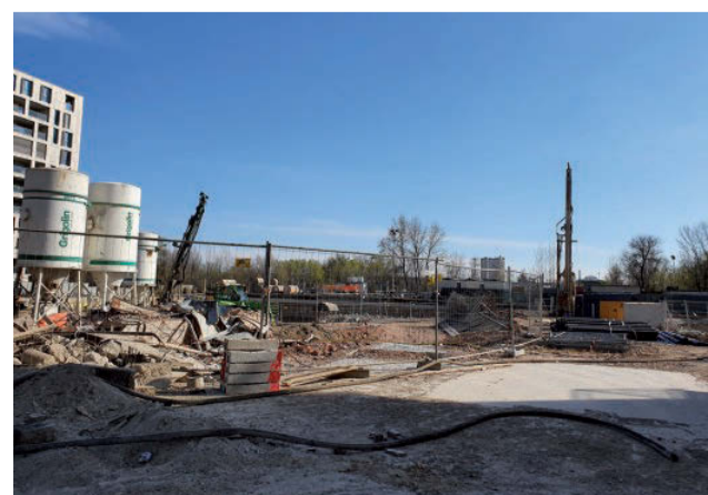
L'area di via Piranesi 38 dopo la demolizione dei due edifici
