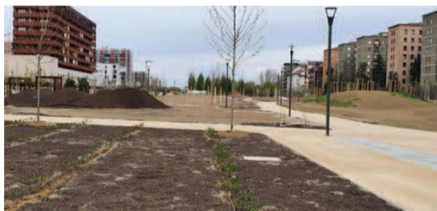
L'area precedentemente destinata alla realizzazione della Biblioteca, fra viale Umbria, via Monte Ortigara e via Cervignano
