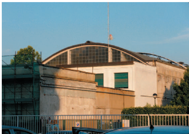
Lavori all'Arci Corvetto
