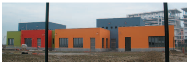
L'asilo in costruzione
