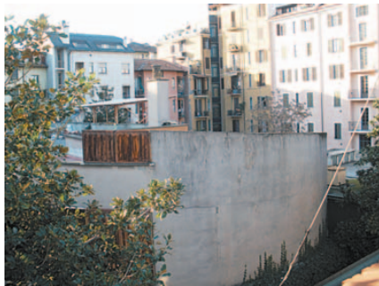
La parete dell'ex garage
