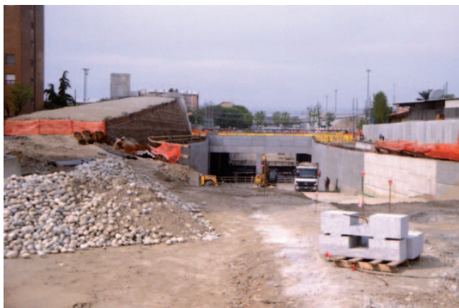
Vista da via Sulmona; sulla sinistra il terrapieno per la passerella
