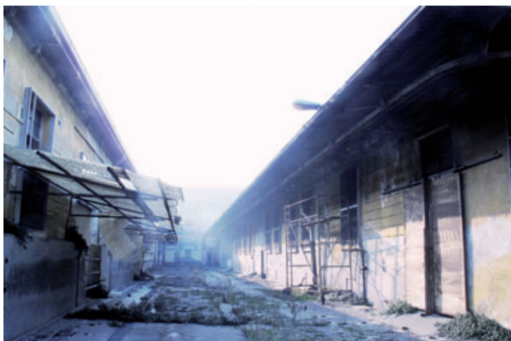
Edifici fatiscenti all'interno dell'ex macello
