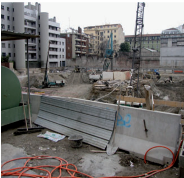
Lavori in corso in via Maffei
