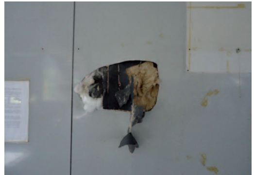
Le lane minerali all'interno delle pareti
