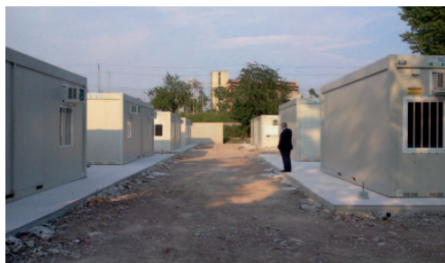
Veduta esterna dei 6 container che ospiteranno le camerate, ciascuna per 24 persone.
