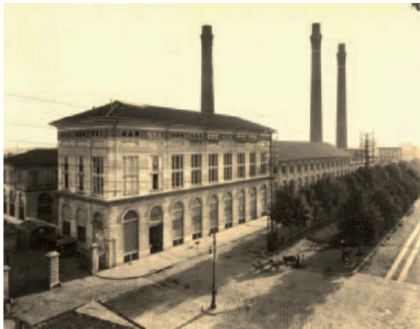
Centrale termoelettrica in piazza Trento (Archivio AEM)
