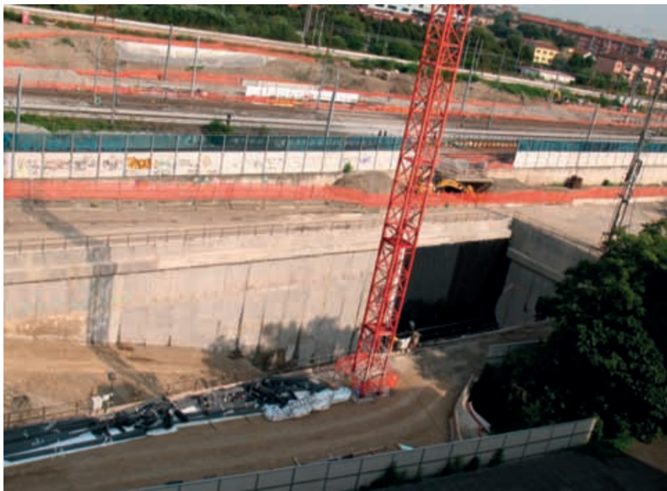
Nella foto del cantiere, opera del nostro lettore Marco Vergini, si ha una panoramica completa: in primo piano lo scavo che ospiterà la stazione della Metro 4 dove è visibile uno dei cerchi dove spunteranno le talpe. In secondo piano, dietro una ruspa, l'ingresso del sottopassaggio nord della stazione Forlanini FS, posto esattamente nel luogo dove passerà la nuova via Ardigò. Più sopra i 6 binari (due del Passante, due della cintura e due merci) in fase di spostamento, e sullo sfondo i binari per Bologna e Genova.
