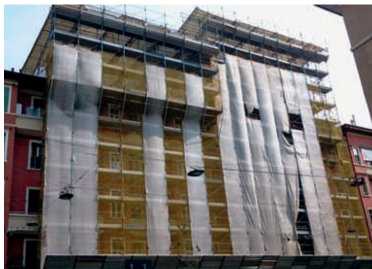
Lavori fermi nel lotto di via Tommei 3 e 4
