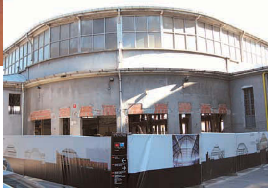
Lavori in corso al Palazzo del Ghiaccio
