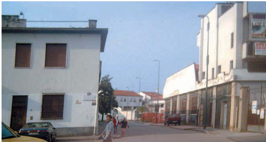
A sinistra la Casa d'Aste(futura sala giochi), a destra i loft in costruzione, in fondo al centro la Chiesa di San Galdino
