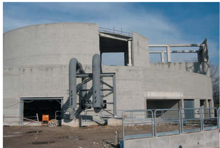
A sinistra: L'impianto in costruzione
