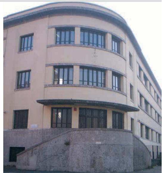
La ex scuola elementare di via Zama
