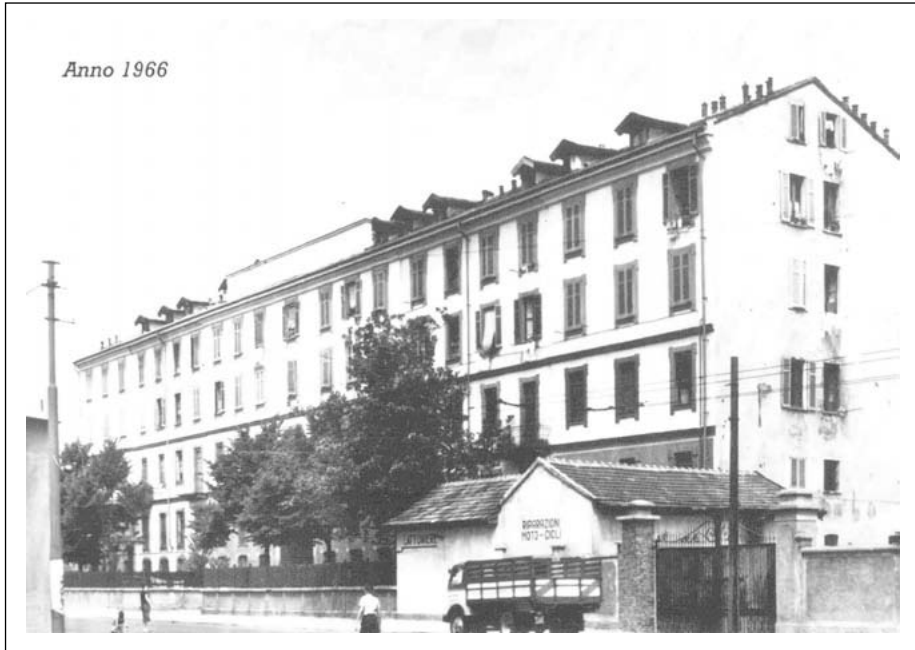
L'abitazione per operai di via Tertulliano 25
