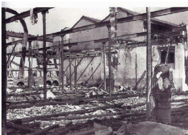
Il deposito dopo i bombardamenti dell'agosto 1943
