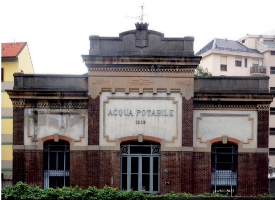
La facciata della centrale in via Anfossi 40
