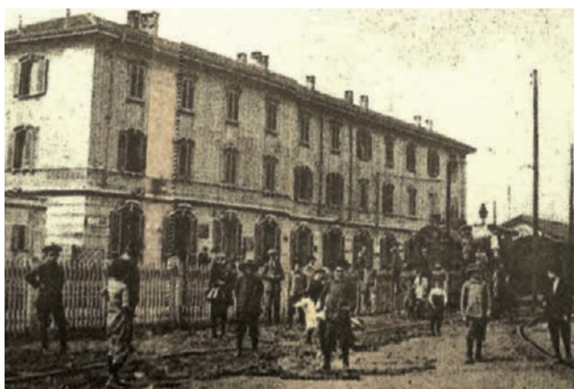
1907- La vecchia stazione ferroviaria di Rogoredo prima della sua demolizione
