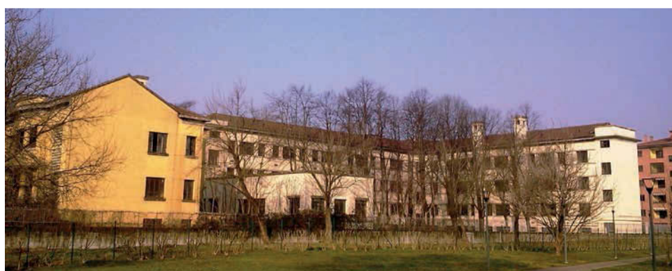
Vista dal retro degli ex edifici scolastici
