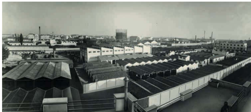
1950: quando i gasometri facevano paesaggio industriale. Qui il gasometro di via Orobica, a sud dello Scalo Romana, smantellato nel 1992. ©Archivio Boehringer
