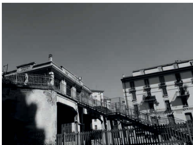
La stazione oggi
