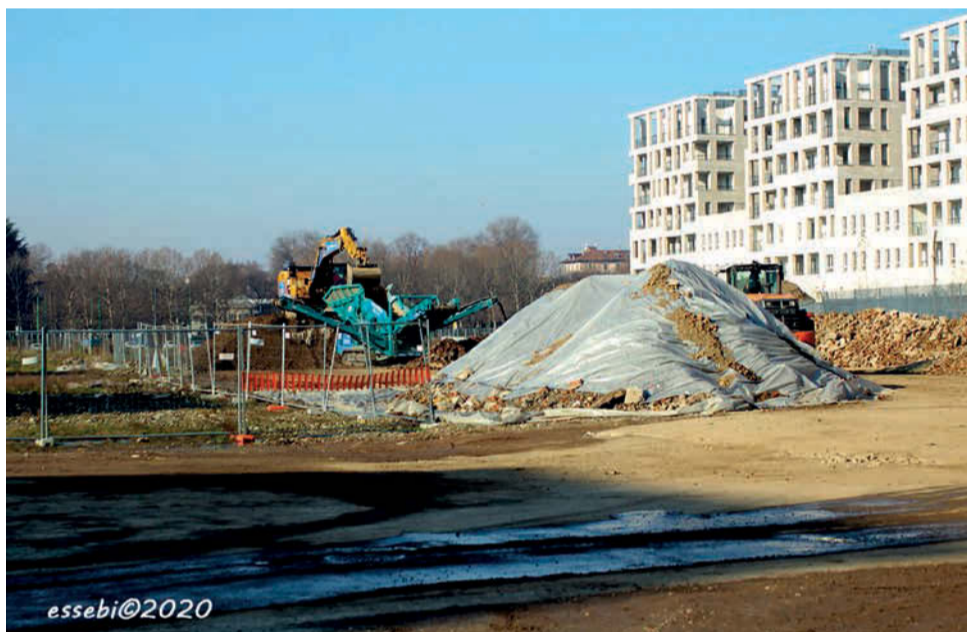
Lavori di bonifica a Porta Vittoria
