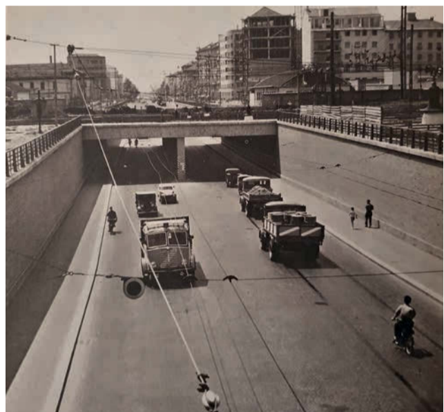
1955 - Sottopassaggio di viale Molise
