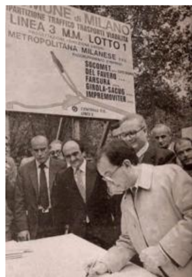
Il sindaco Carlo Tognoli apre il primo cantiere della M3-1981
