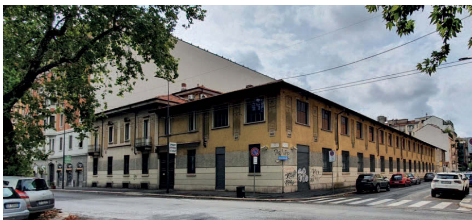
L'edificio di viale Umbria destinato alla demolizione
