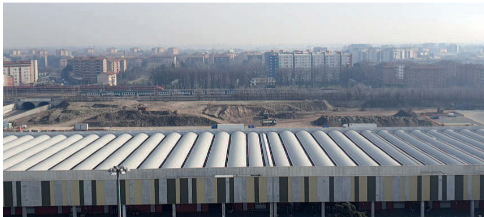
Lavori nell'area del nuovo capannone di Milano Ristorazione
