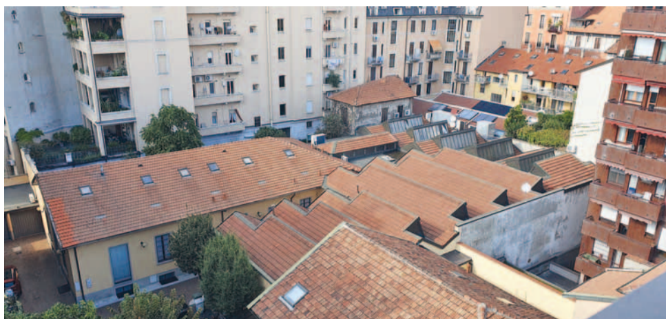
Cortile interno al civico 3 con le pre-esistenze produttive
