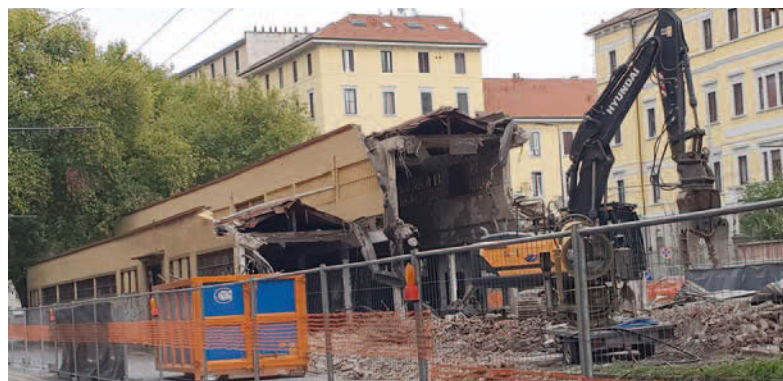
La demolizione dell'ex mercato comunale
