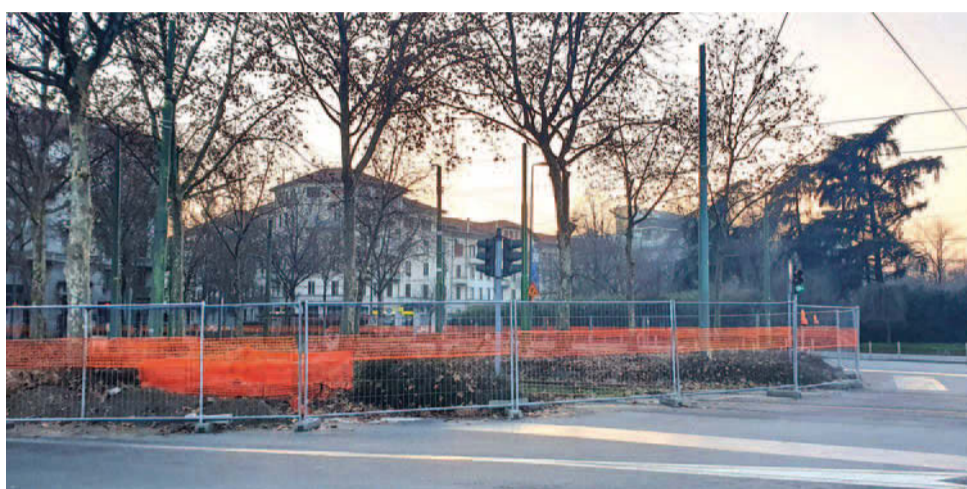
Lavori in piazza Cappelli
